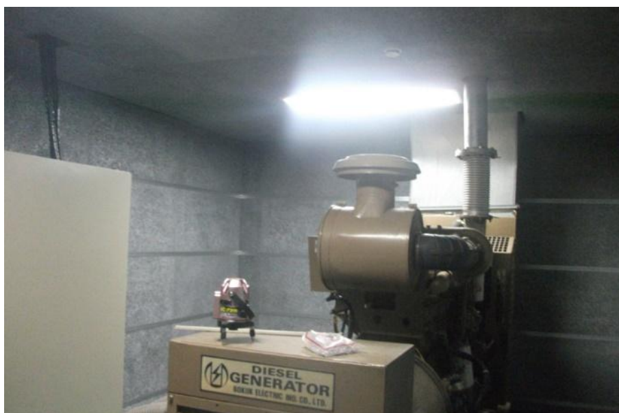
شکل (۱۴): استفاده از فوم آلومینیومی در ساخت موتورخانه ها
